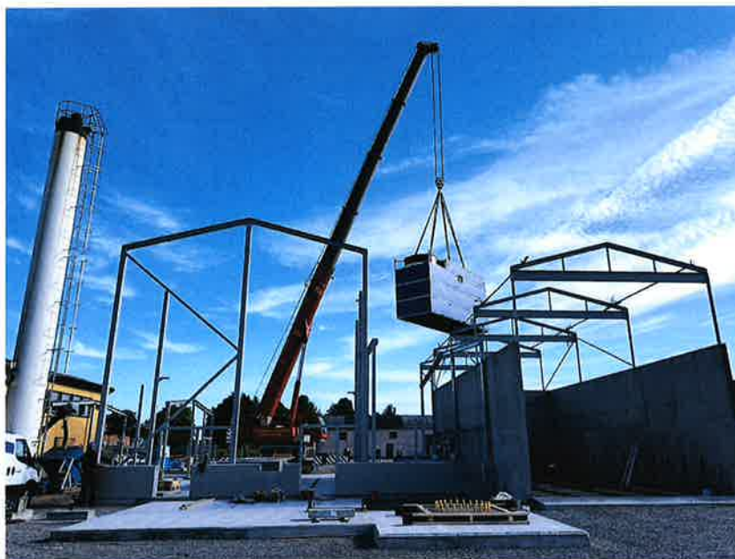
Lyft av nya flispannan som vägde 35 ton
